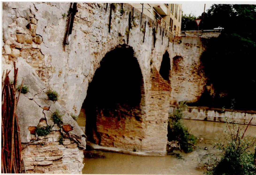
Elementi costruttivi provenienti da una fornace romana esistente in zona e riconducibili alla mole architettonica del ponte del Paleotto.
