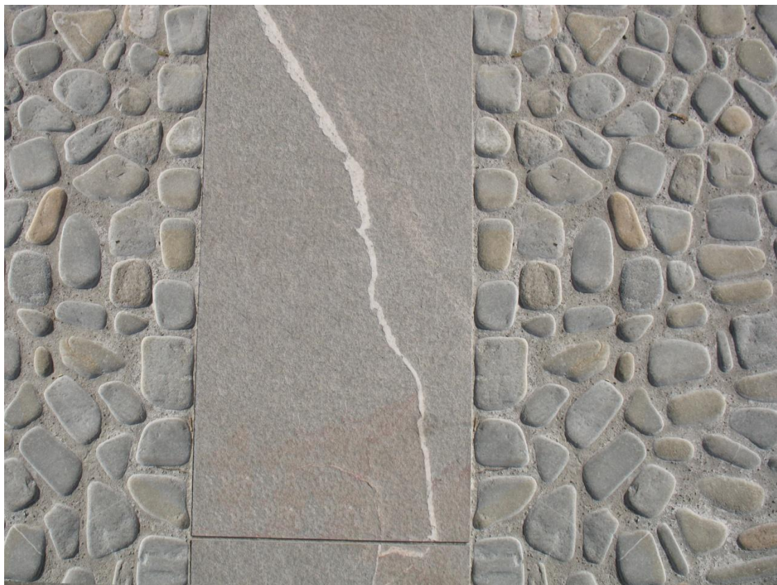
Figura 4-2 : Particolare della pavimentazione di progetto: carraia in pietra con acciottolato laterale
